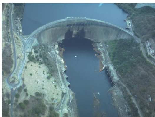
Imagem: Hidroelétrica de Cahora Bassa. http://mocambique2.blogs.sapo.pt/arquivo/CABORA%20BASSA%20-%20outra%20vista_resize.jpg
